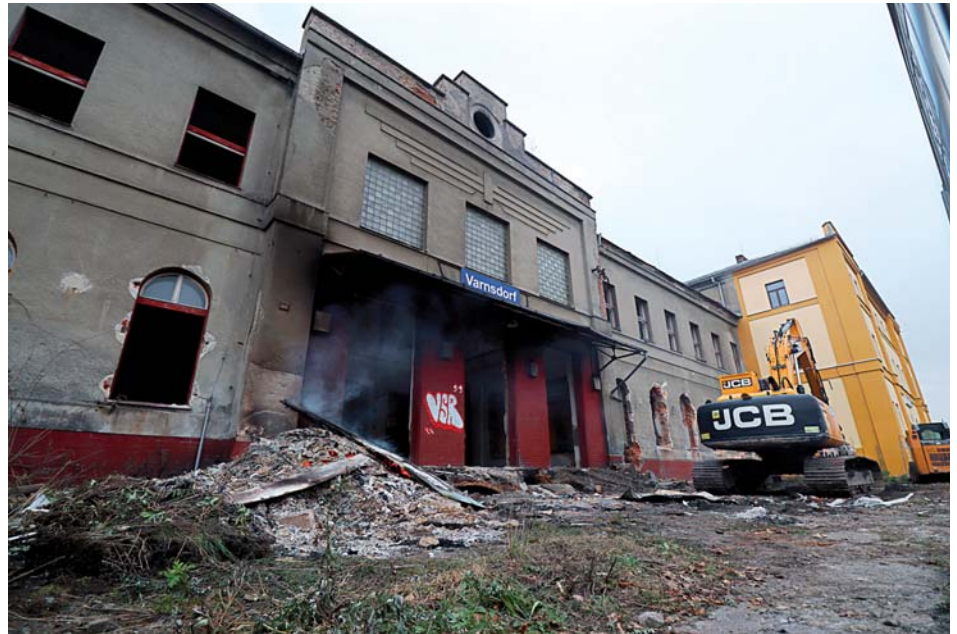
Im November 2020 wurden zwei Drittel des historischen Bahnhofs von Varnsdorf abgerissen.
